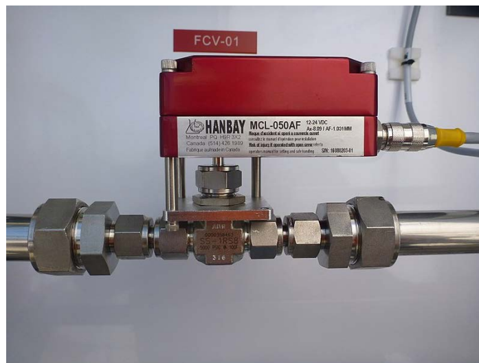
Figura 1.5 - Válvula Hidráulica (fonte: Wikipedia )
